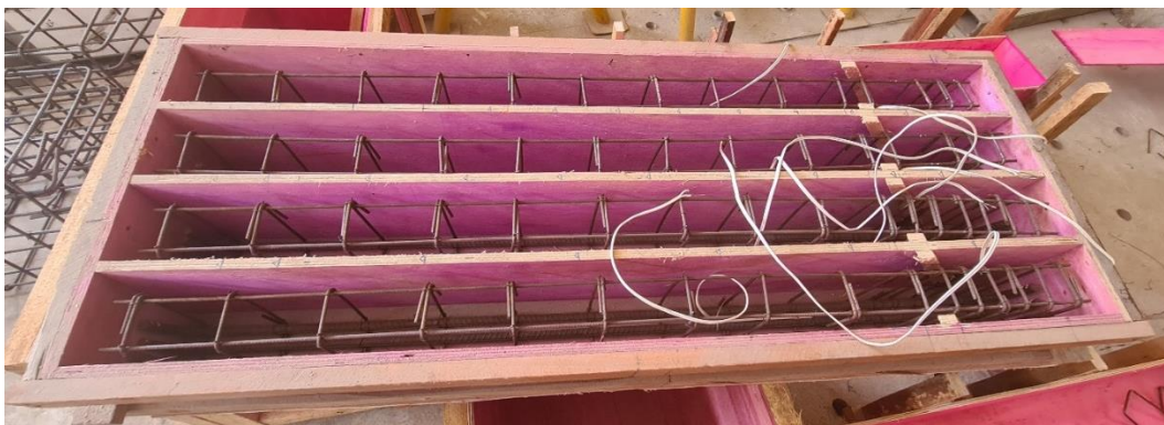
Figura 3.10 – Formas com as armações das vigas
