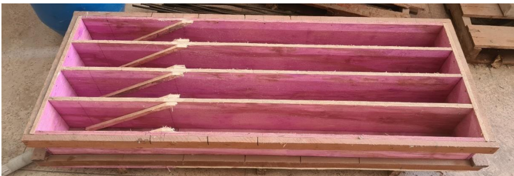
Figura 3.9 – Formas das vigas
